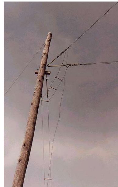
Speisung der Rhombus-Antenne mittels einer "Hühnerleiter". Auch dieses Detail sah in Bülach der Schweizer Perfektion entsprechend viel Professioneller aus.
