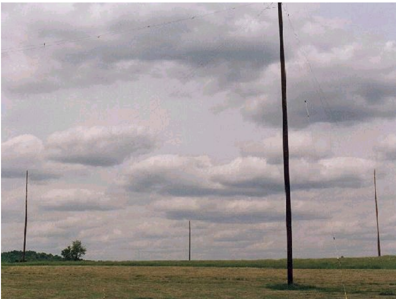
Die Masten einer Rhombus-Antenne in den USA. Man vergleiche die Grösse mit dem Baum im Hintergrund. Der schweizerischen Perfektion entsprechend wurden in Bülach natürlich nur makellose Holzmasten verwendet.
